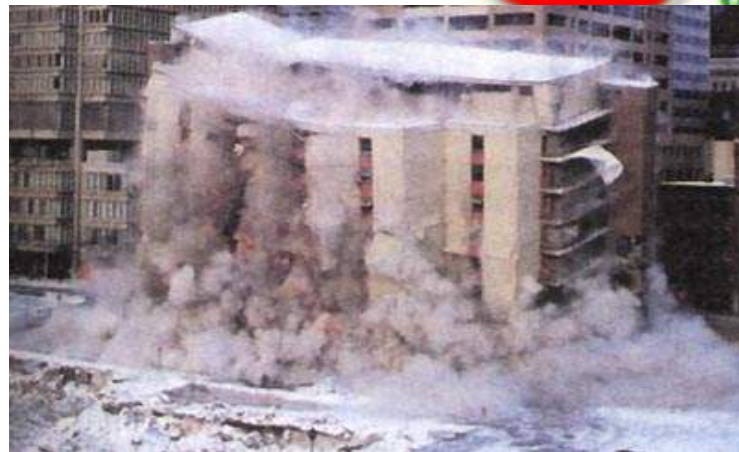
拆除危旧建筑
